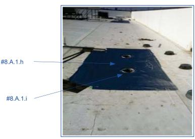
SCOPE OF WORK – TYPICAL SCUPPER – TPO # 8
