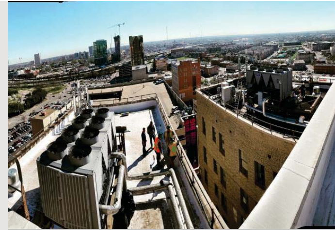
TPO Dallas, TX
